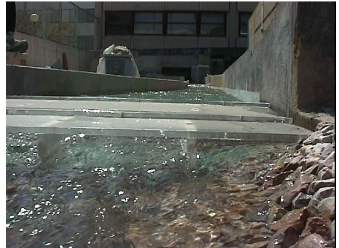
FOTO 54.- Vista desde aguas abajo del flujo en carga a través del vano de la margen izquierda del cauce. Se aprecia el peralte transversal en los vanos contiguos.
