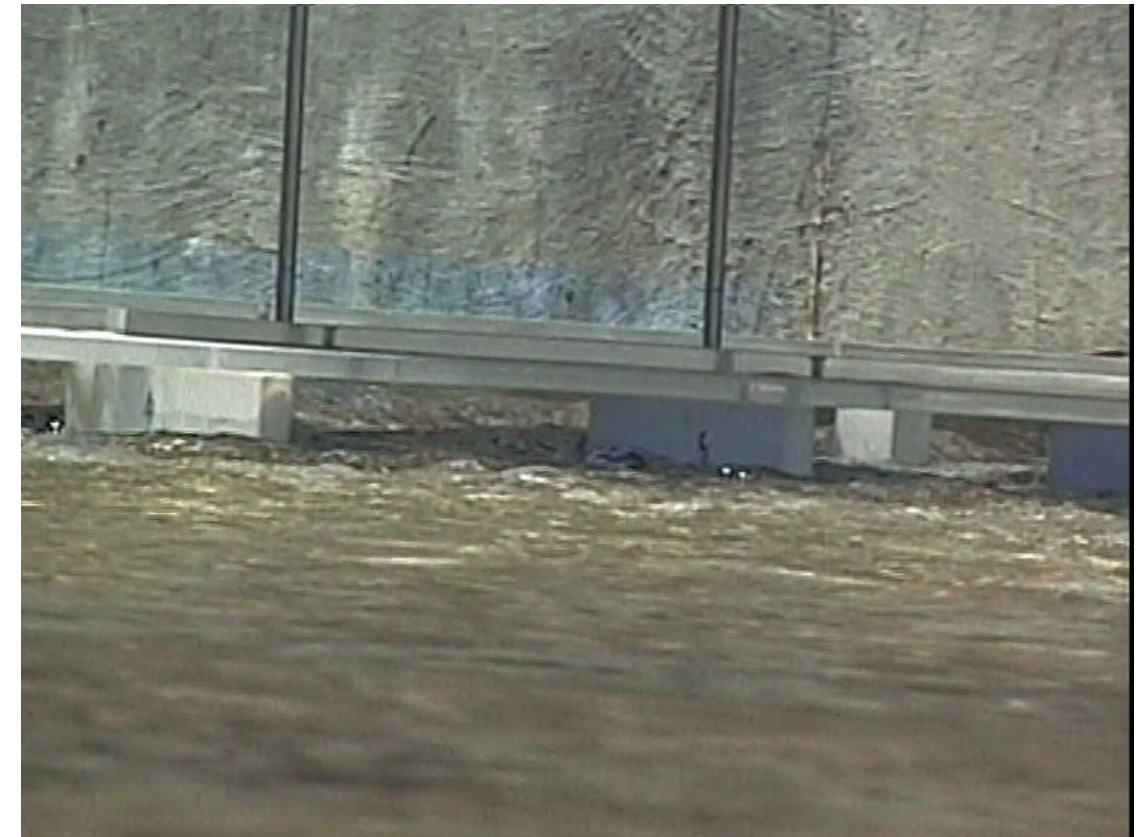
FOTO 41.- Vista desde aguas abajo del flujo bajo los puentes. Zona central del cauce.
