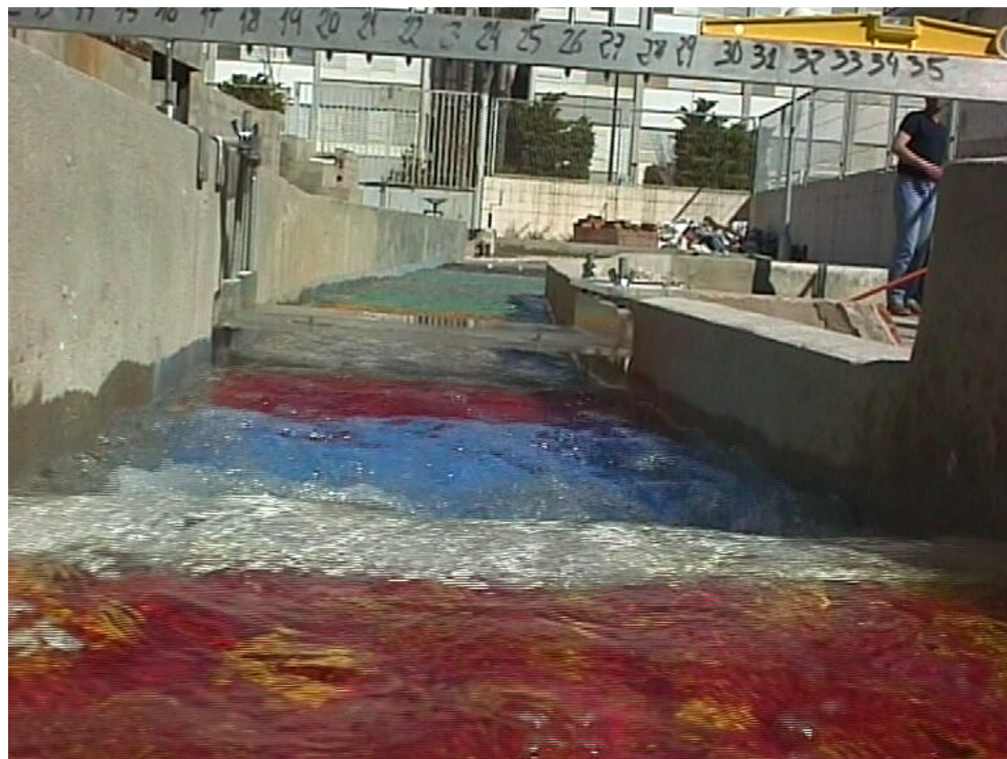
FOTO 32.- Vista hacia aguas abajo, del flujo vertiente por el Salto de San Gabriel. En segundo término, el puente de la C/Paraguay.
