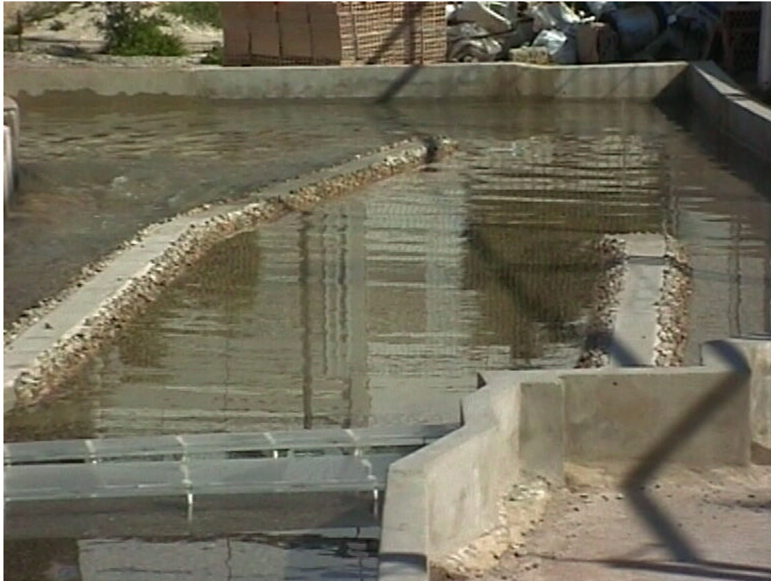
FOTOS 27 y 28.- Zona de desembocadura del barranco de Las Ovejas. Vista de los diques-espigones y balsa de control de niveles del mar.
