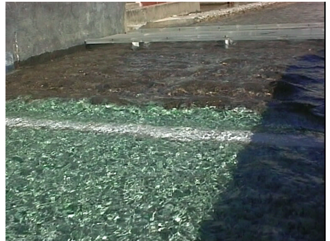
FOTO 34.- Funcionamiento del azud sumergido de entrega al mar. Se aprecia un pequeño oleaje superficial que se amortigua antes de llegar a la sección de los puentes.
