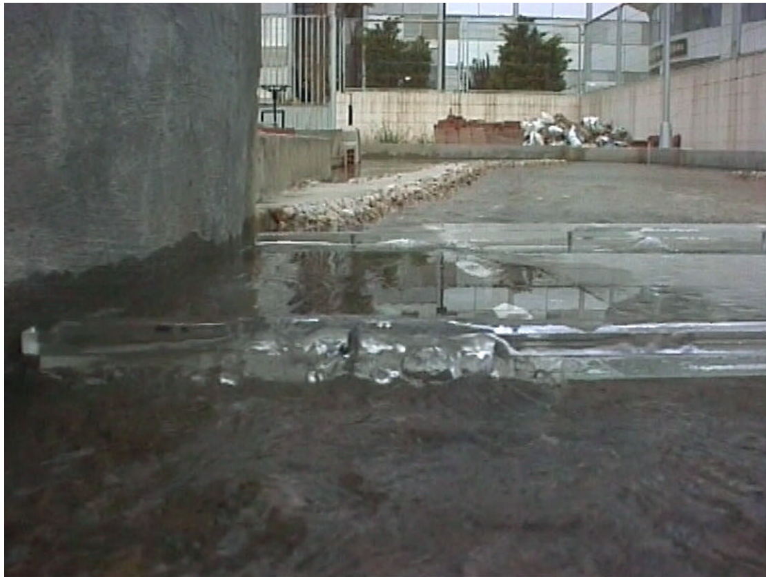
FOTOS 65 y 66.- Los vanos de la margen izquierda de los puentes de la N-332 y del ferrocarril funcionan en carga y el efecto de remanso provoca el vertido sobre los tableros.
