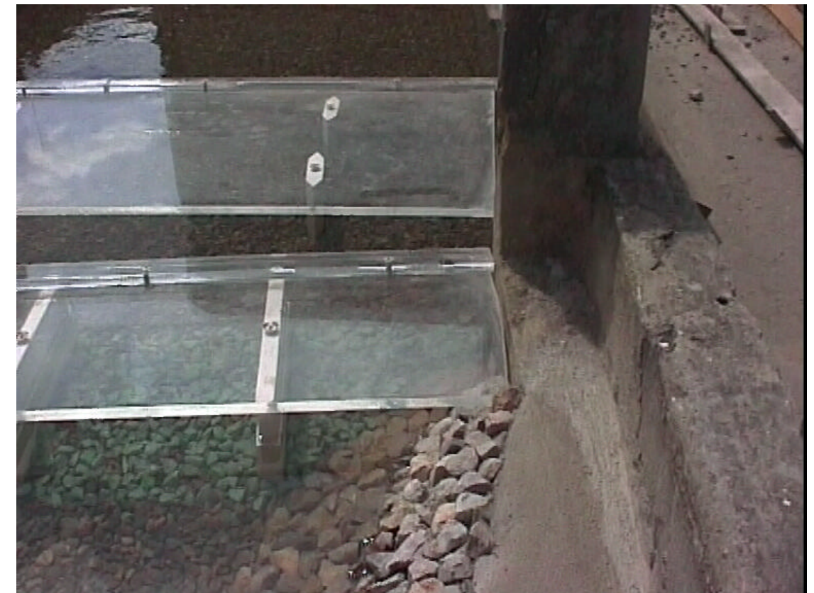
FOTO 26.- Vista desde aguas debajo de la trayectoria del flujo y su obstrucción parcial por el dique-espigón.
