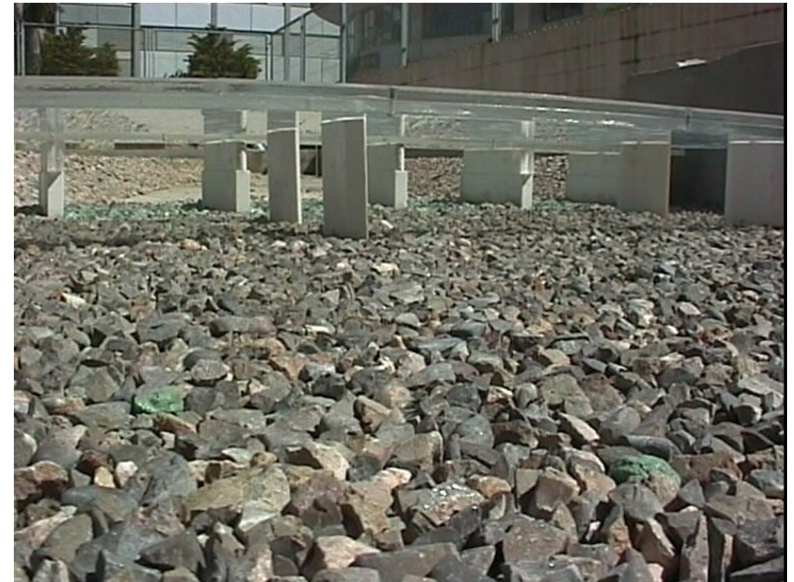
FOTO 18.- Vista desde el eje del cauce y en la dirección del flujo, del esvaje e interferencia mutua de las pilas, respecto del flujo en avenida.
