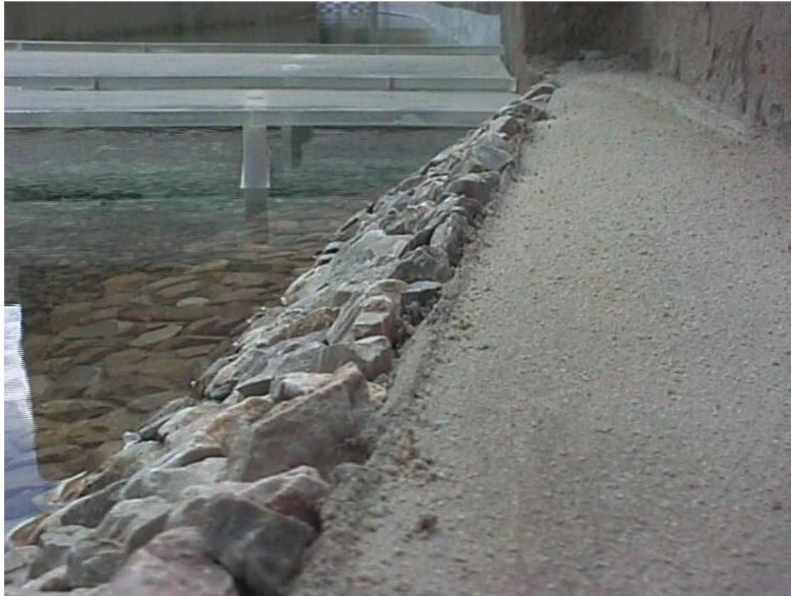
FOTO 23.- Vista desde la coronación del espigón, del efecto de cierre del flujo.
