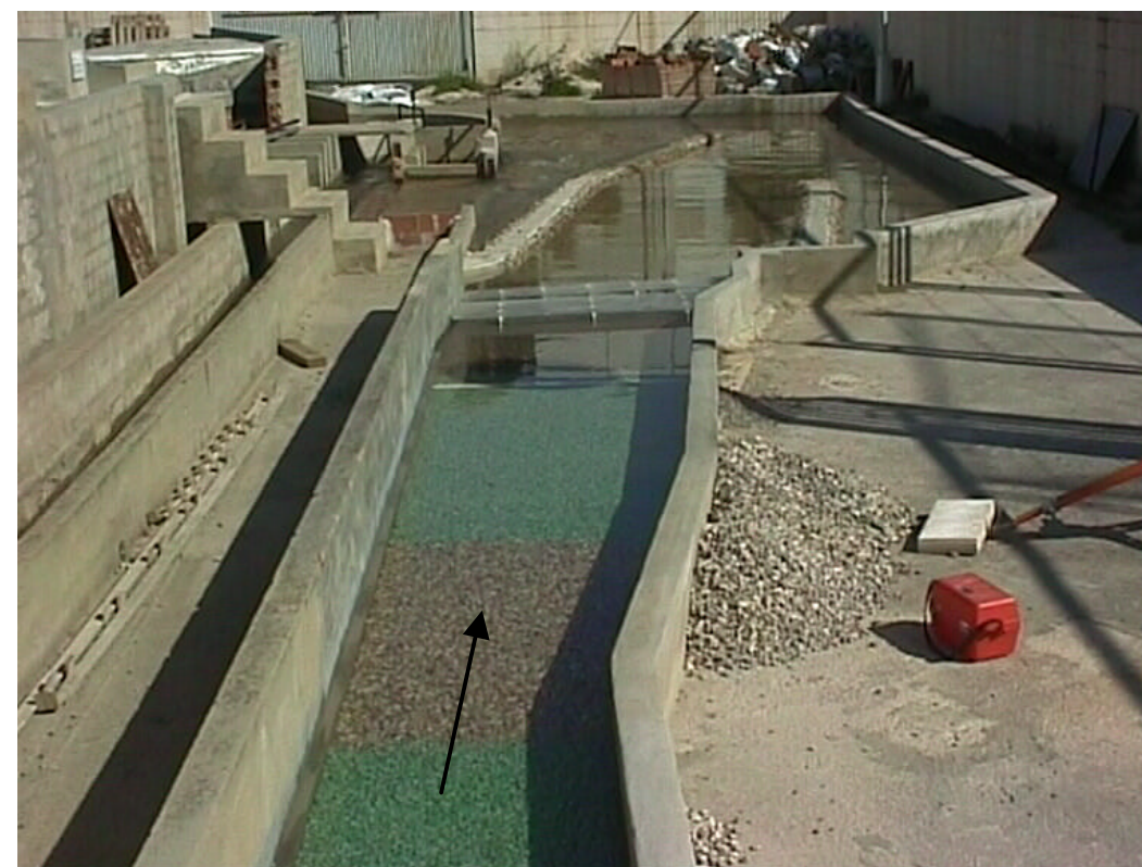
FOTO 14.- Escolleros de la plataforma con batimétrica -2.00 m. Al fondo, el azud de entrega al mar y los puentes de la desembocadura.
