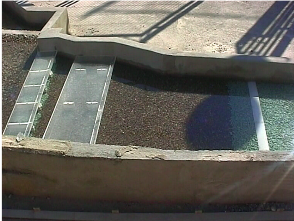
FOTOS 15 y 16.- Nuevo Azud de reintegro al mar. Separa sendas plataformas a cota -2.00 m. y a cota -2.50 m.(en ésta se ubican los puentes de la N-332 y ffcc.)
