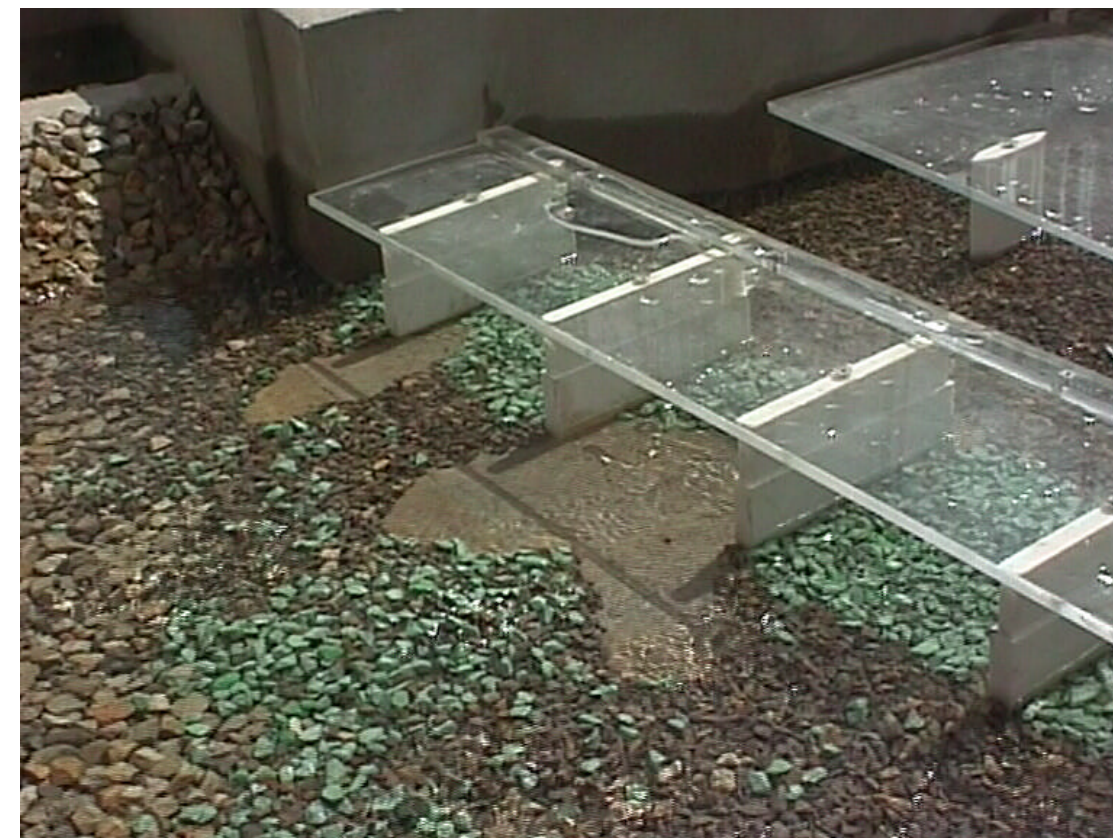
FOTO 75. Centro y margen derecha puente ferrocarril
