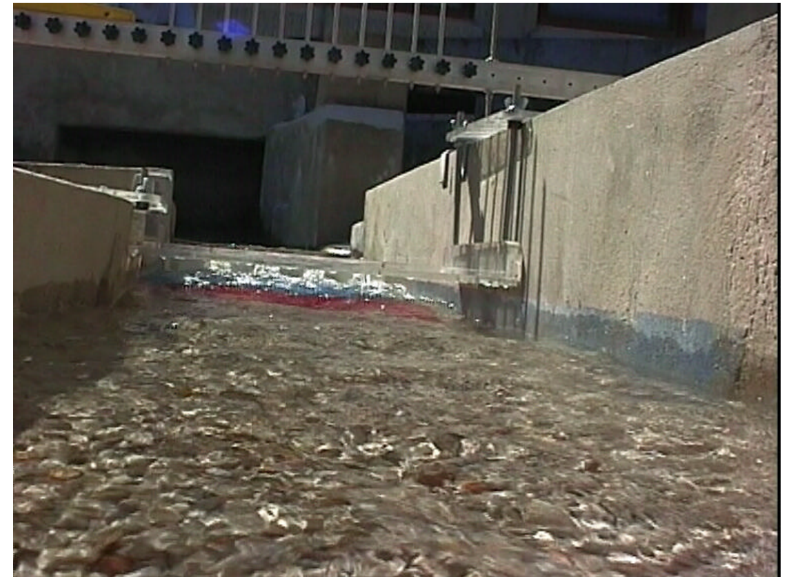
FOTO 33.- Vista hacia aguas arriba del paso del flujo bajo el puente de C/Paraguay.
