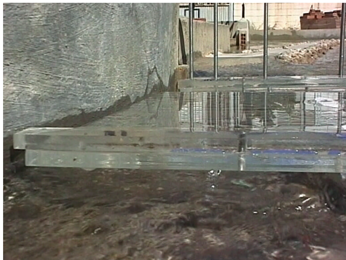
FOTOS 91 a 93.- Paso exento del flujo bajo los vanos de la margen izquierda del encauzamiento.
