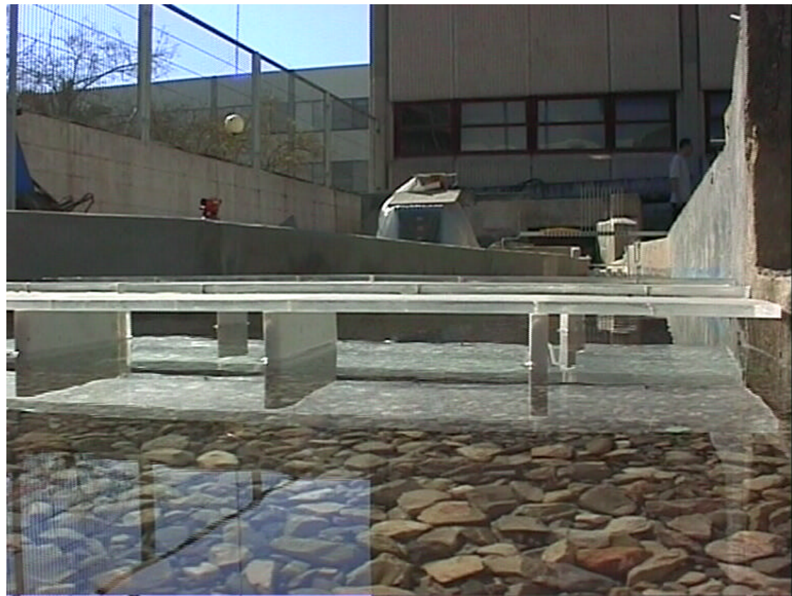
FOTO 84.- Vista desde el nuevo arranque del espigón, de los vanos de la margen izquierda del encauzamiento. Obsérvese la mejora en la sección hidráulica efectiva.
