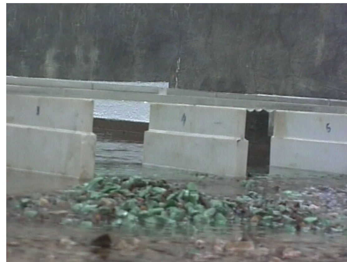
FOTO 79. Aguas abajo zona central puente ferrocarril.
