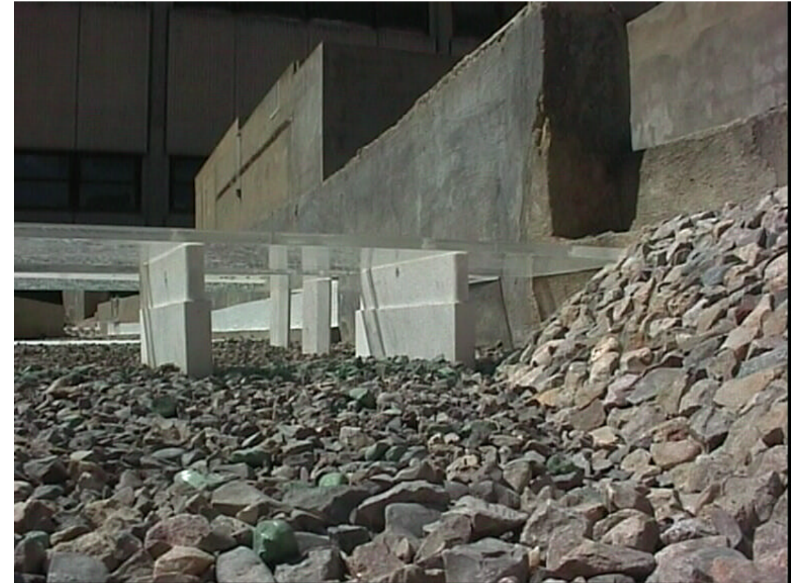
FOTO 21.- Vista desde aguas abajo, del efecto de cierre que genera el espigón.
