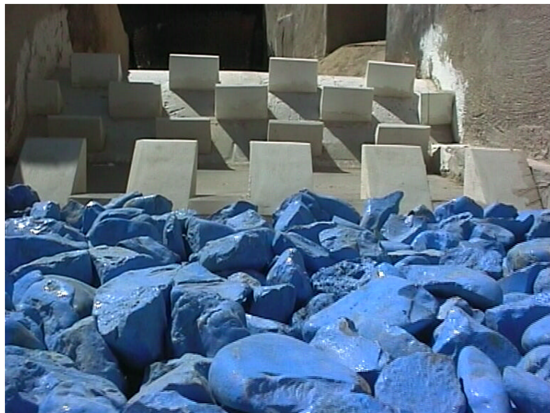
FOTO 7.-Primer azud del encauzamiento (de San Gabriel), con dientes deflectores del flujo y disipadores de energía colocados al tresbolillo en el cuerpo del azud. En primer término, el puente de la calle Paraguay.
