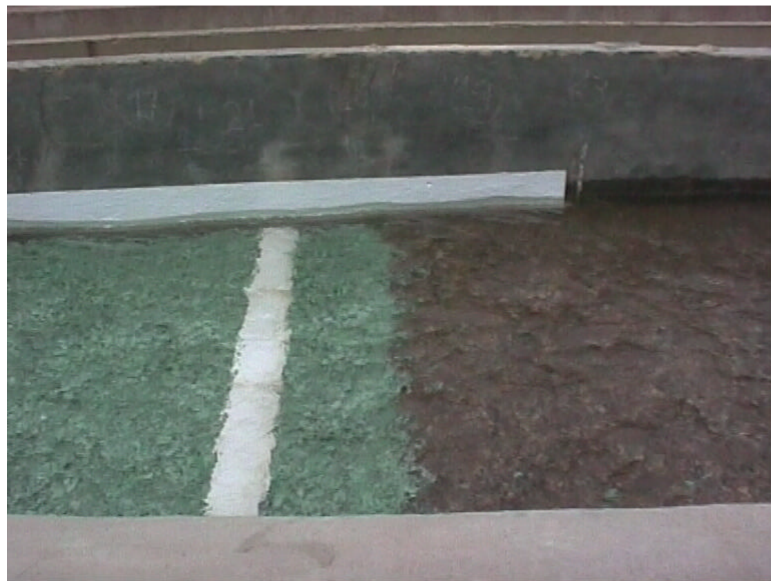
FOTO 99.- Resguardo en las plataformas a cota -2.00m. y -2.5 m. a ambos lados del azud de entrega al mar.
