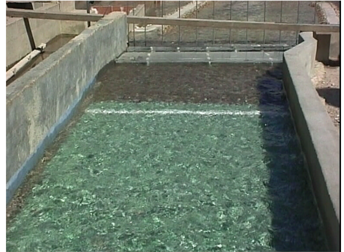
FOTO 63.- Flujo sobre el azud de reintegro al mar. Su situación permite amortiguar rápidamente el oleaje formado a su paso antes de llega a los puentes.
