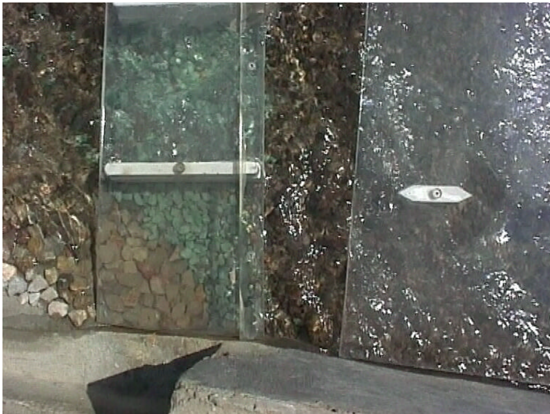
FOTO 53.- Vista cenital de la entrada en carga del vano del puente del ferrocarril. En el oleaje superficial se aprecia el esviaje del flujo hacia la margen derecha.
