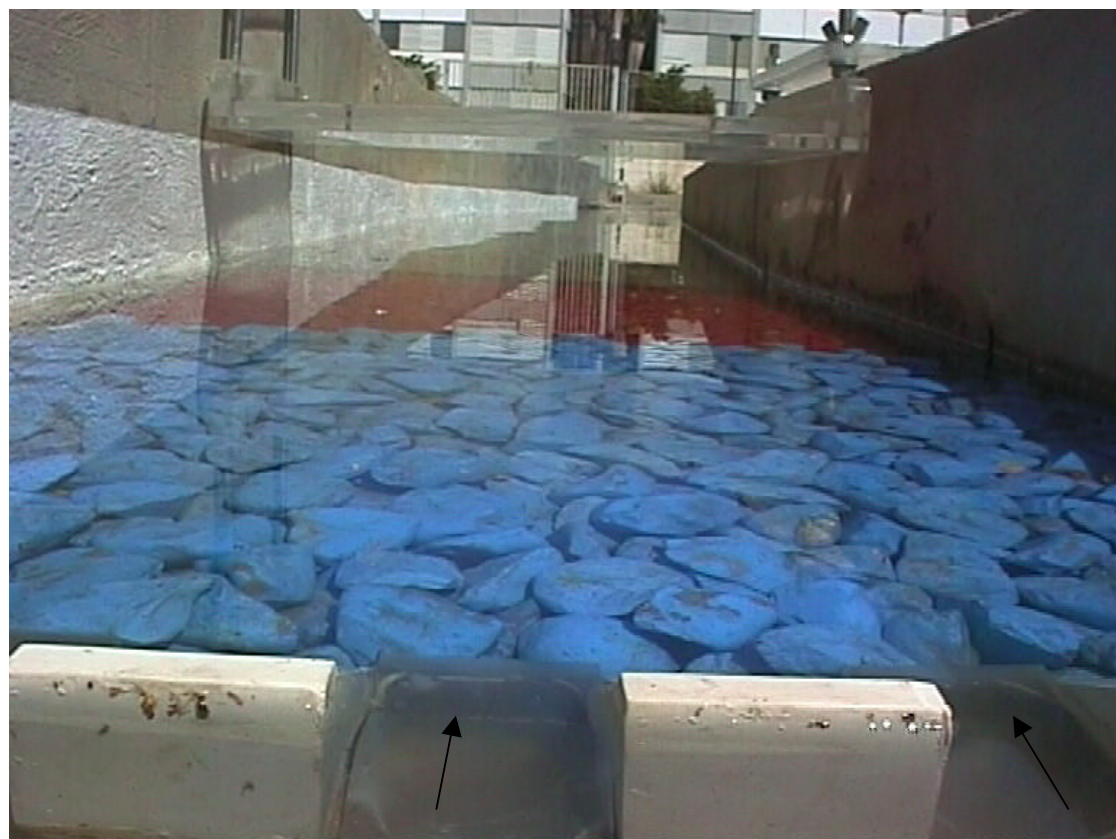
FOTO 11.- Vista, desde el umbral del azud de San Gabriel, del escollero del lecho y puente de la calle Paraguay. Marea y caudal de avenida nulos (Situación Q).
