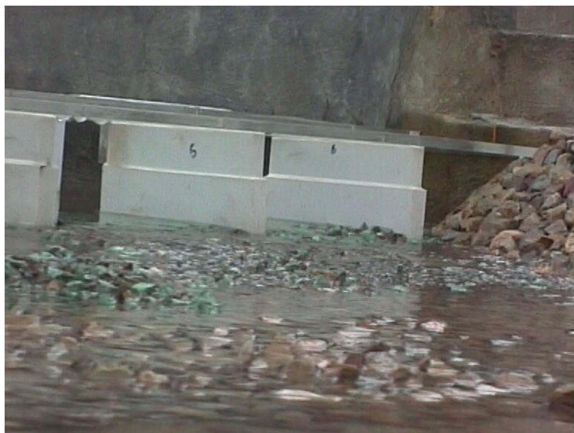
FOTO 77.- Margen izquierda aguas abajo puente ferrocarril.
