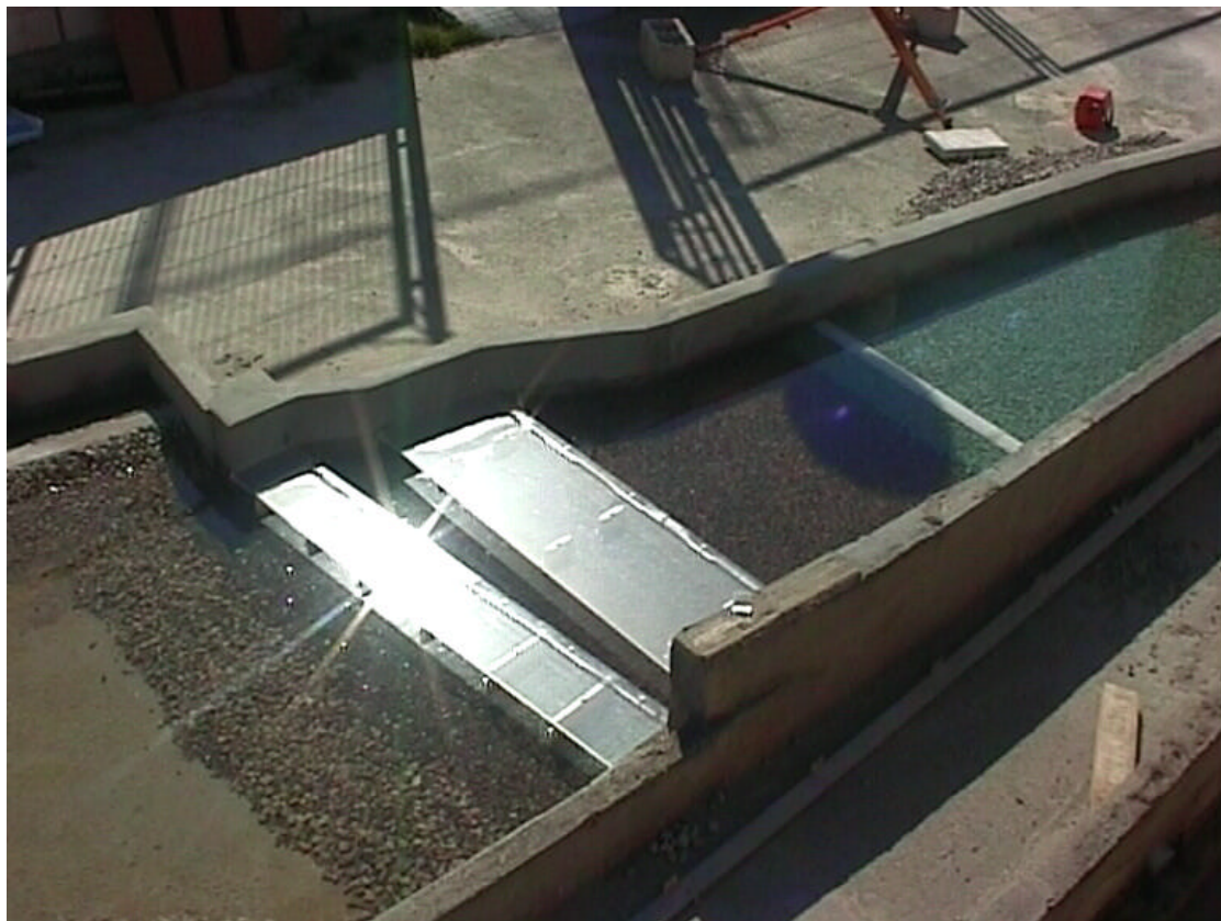
FOTOS 15 y 16.- Nuevo Azud de reintegro al mar. Separa sendas plataformas a cota -2.00 m. y a cota -2.50 m.(en ésta se ubican los puentes de la N-332 y ffcc.)
