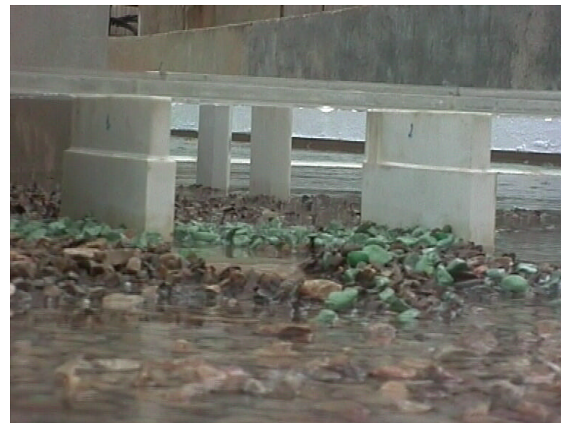
FOTO 78. Aguas abajo margen derecha puente ferrocarril.
