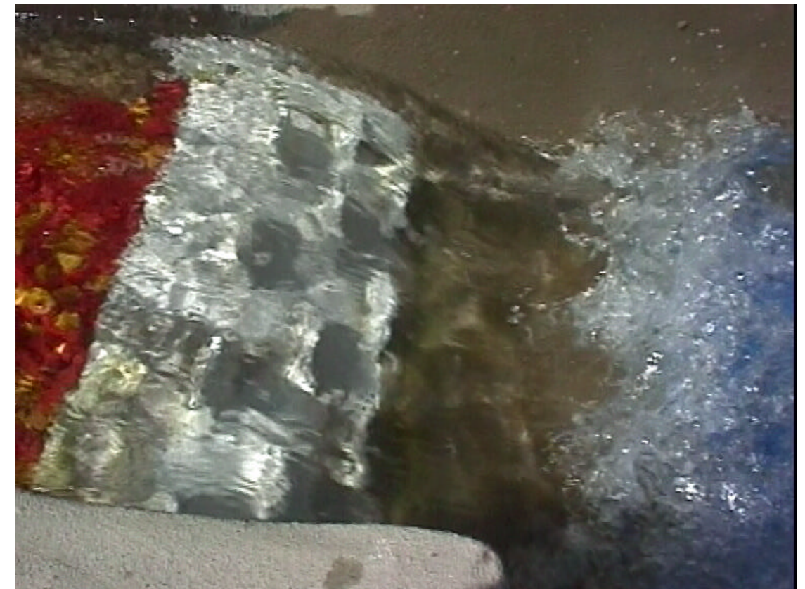
FOTO 60.- Vista transversal del Salto de San Gabriel y su funcionamiento hidráulico adecuado para el caudal de T = 200 años.
