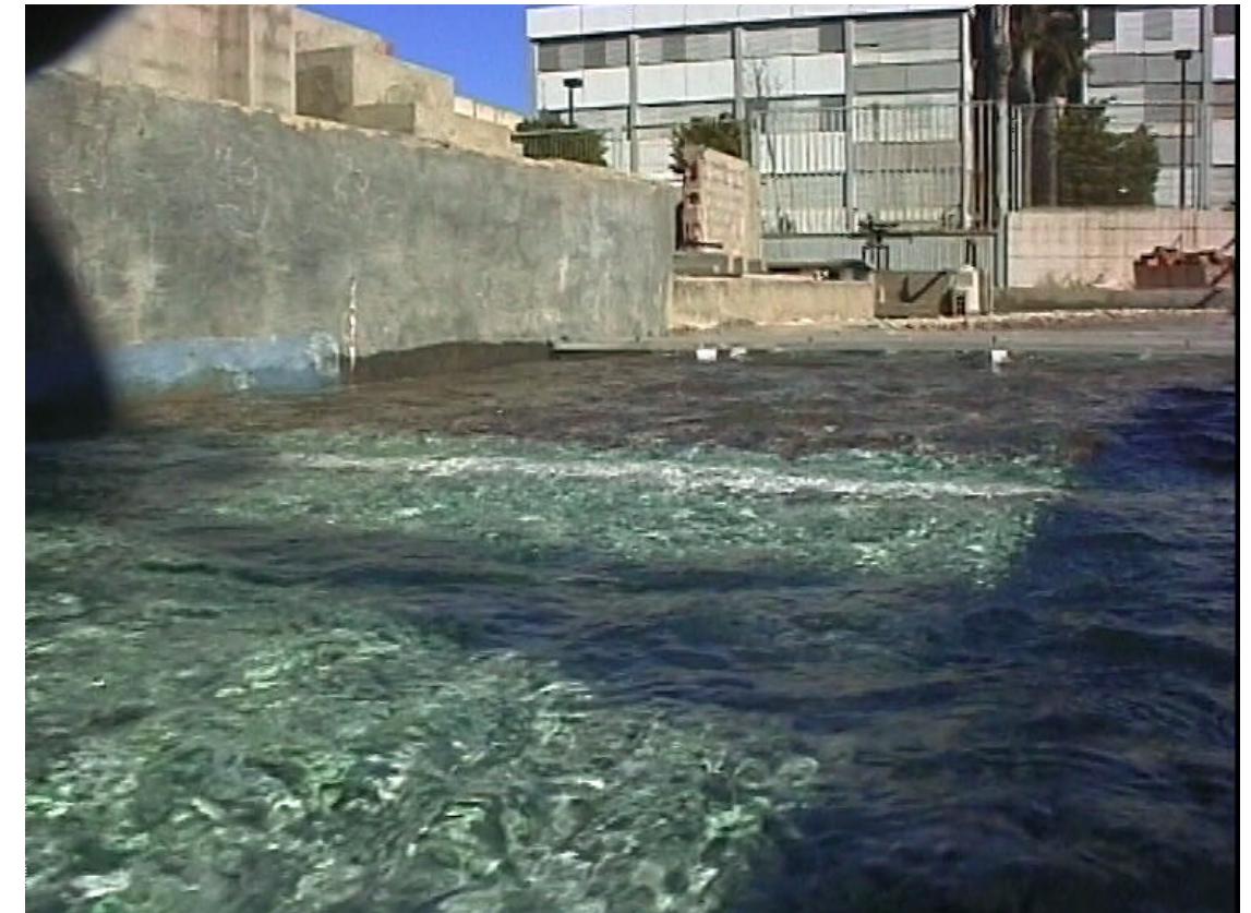
FOTO 50.- Flujo sobre el azud de reintegro al mar. Su situación permite amortiguar rápidamente el oleaje formado a su paso antes de llegar a los puentes.
