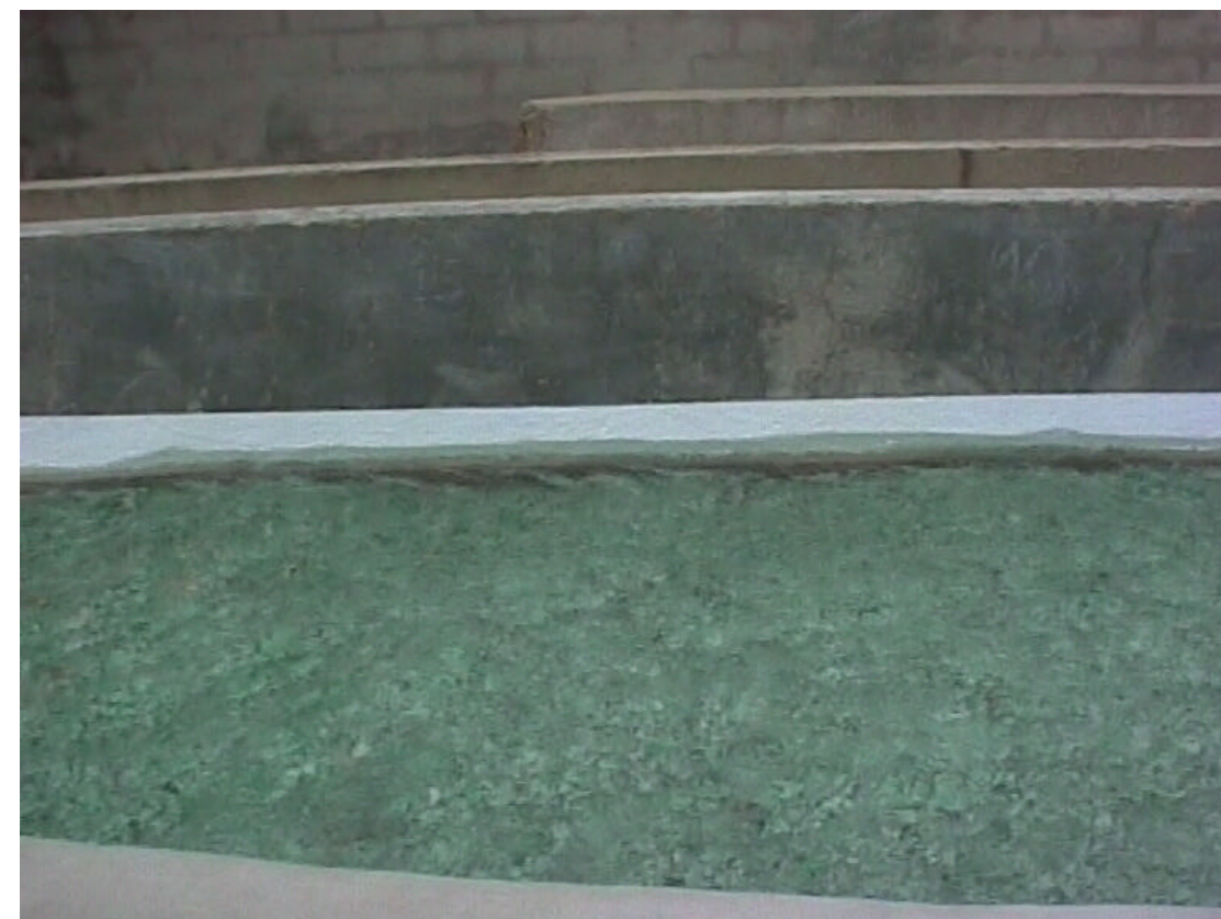
FOTO 98.- Resguardo en la plataforma a cota -2.00m.
