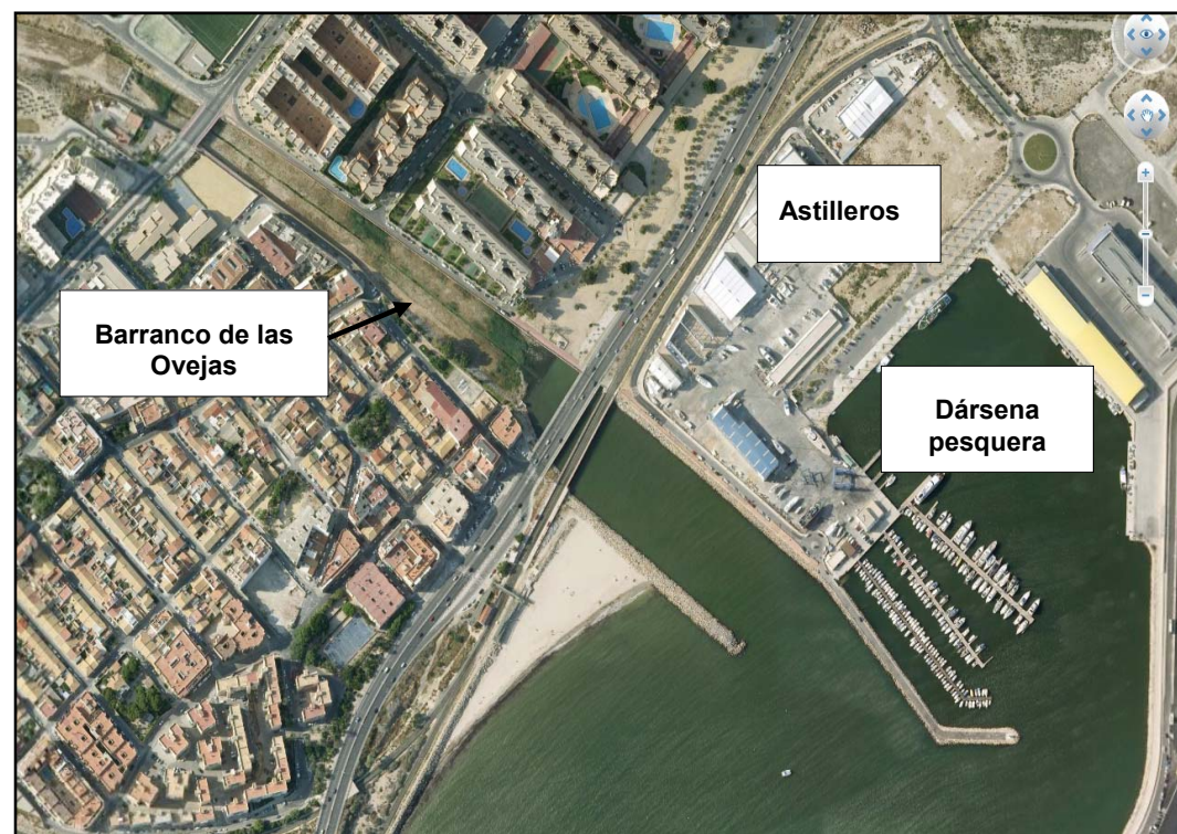
Vista actual del tramo de actuación
